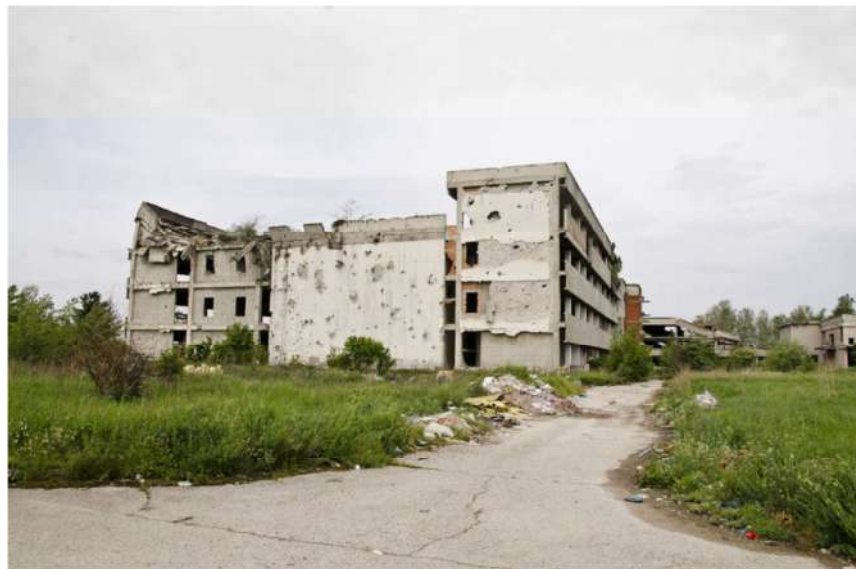
Fotografija 2. Trandžament zgrada televizije sa pristupnim putem – Postojeće stanje
